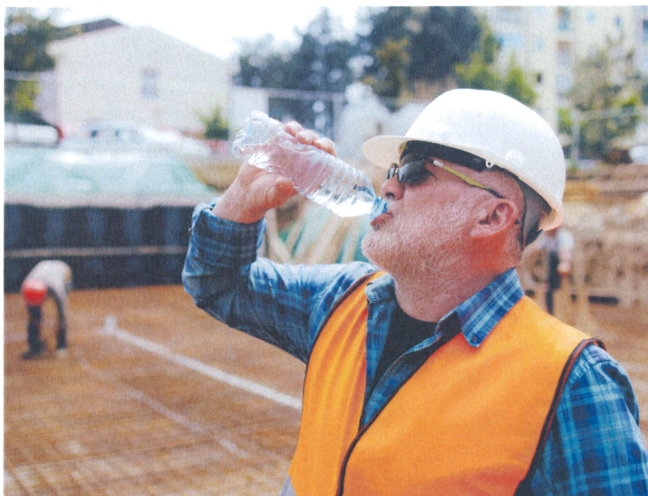
Auf der Baustelle gilt: genügend Flüssigkeit und ausreichend Sonnenschutz.
