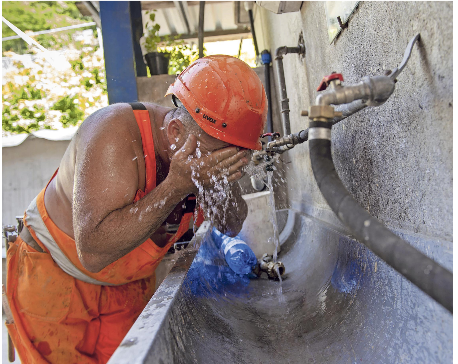
Ein Bauarbeiter kühlt sich ab: Die aktuelle Hitzewelle ist eine Herausforderung für alle, die im Freien arbeiten.
